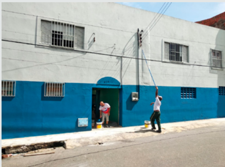
Foto 2 – Foto da fachada do Instituto depois da realização da reforma
