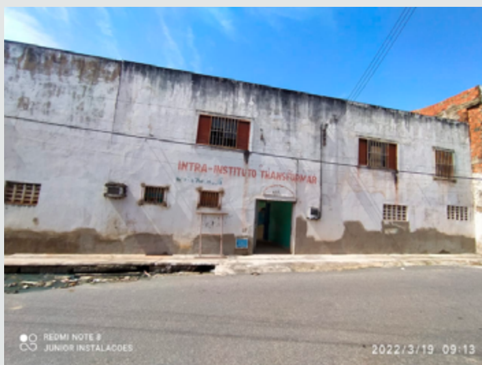
Foto 1 – Foto da fachada do Instituto antes da realização da reforma
